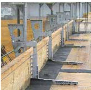
Beim Versetzungs-, Umsetzungs- und Demontagevorgang der BE-FIX® Abschalungssystem Produkte sind ab einer Absturzhöhe von 2 m geeignete Massnahmen zur Absturzsicherung zu treffen.
